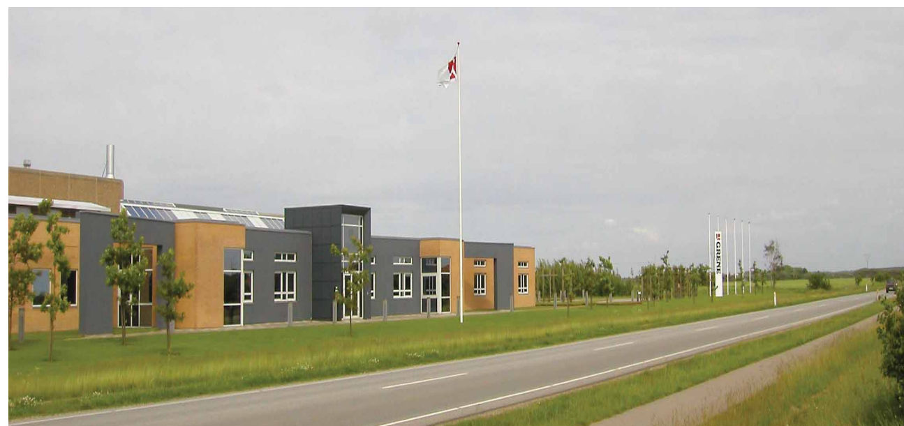
En enkel og tydelig skiltning med en pylon og et flag. Facadeskiltningen består blot af en diskret vinduesskiltning. Ud over det permanente flag er der opstillet en række flagstænger, så der lejlighedsvis kan flages med f.eks. internationale gæsters flag.
