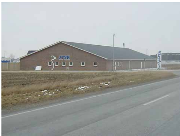
Facadeskilte med enkeltbogstaver giver en tydelig skiltning og en skiltning, der også tager hensyn til bygningen.
